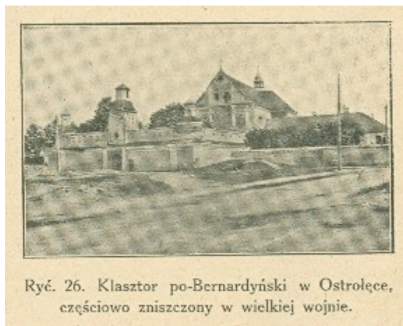
Ryc. 26. Klasztor po-Bernardyński w Ostrołęce, częściowo zniszczony w wielkiej wojnie.
